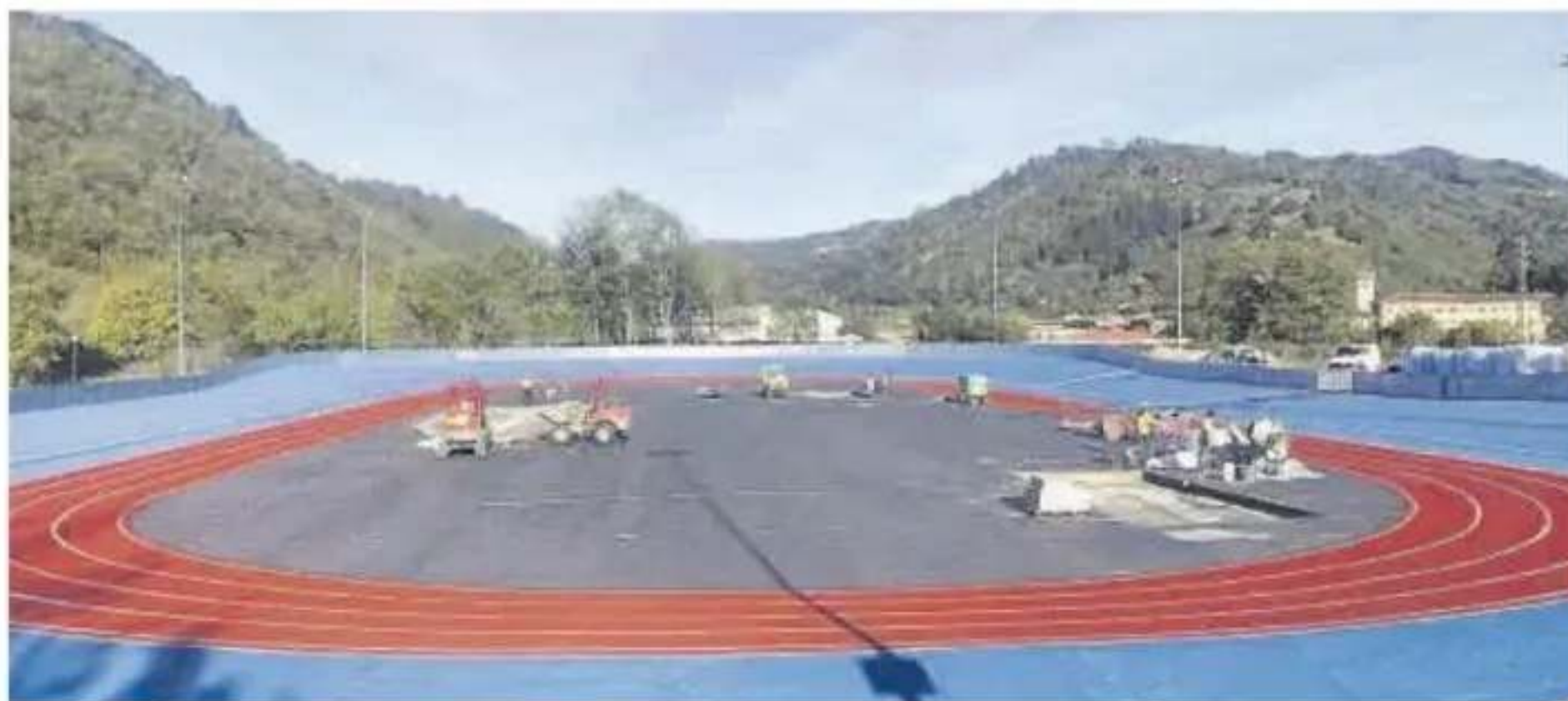
Las obras de la pista de atletismo en el velódromo de Laviana. A la derecha, una recreación de cómo quedará la instalación.
